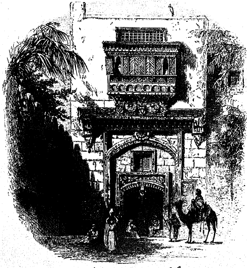
لوحة ٨٣ - بيت الوالى بمنفلوط في صعيد مصر ، مما يدل على وجود عمارة سكنية إسلامية أصيلة يحتذيها الأهالى في الأقاليم . عن لوحة لفنان مجهول .
